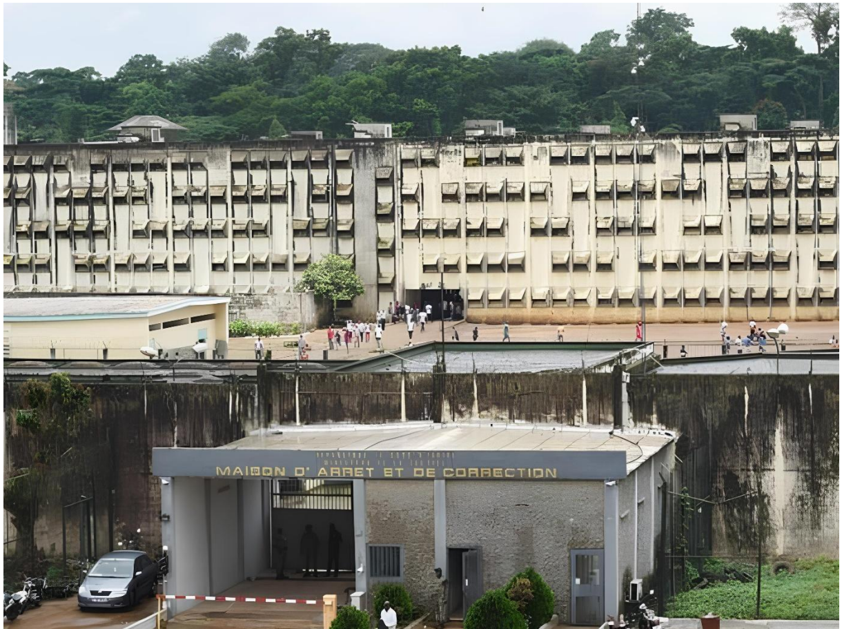
Pôle pénitentiaire d'Abidjan, novembre 2023, source yop.l-frii.com
